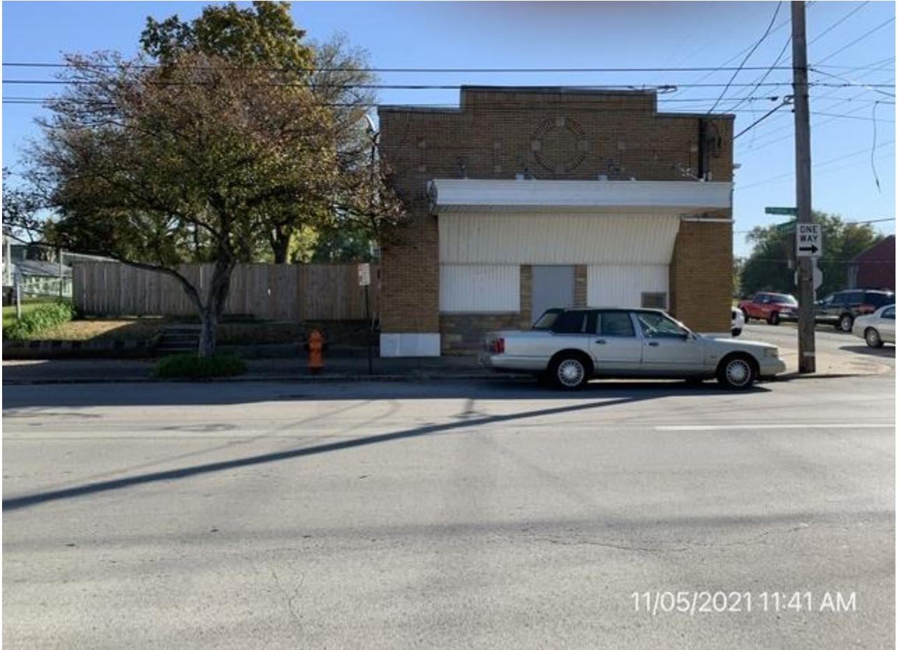
Across S. Preston St.
